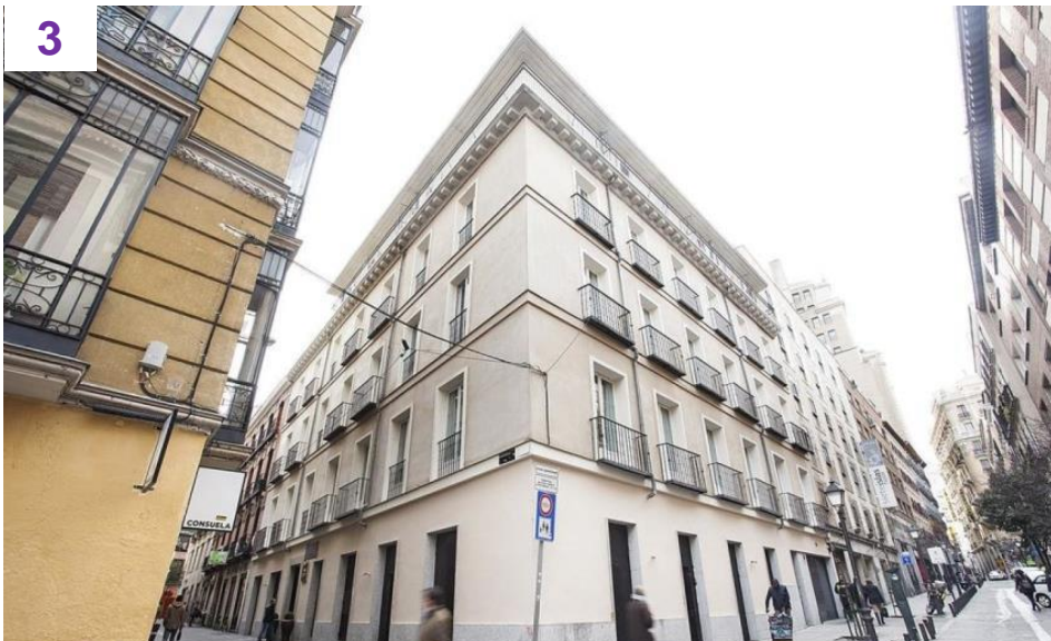
3 Edificio San Onofre, 5 (Madrid)
